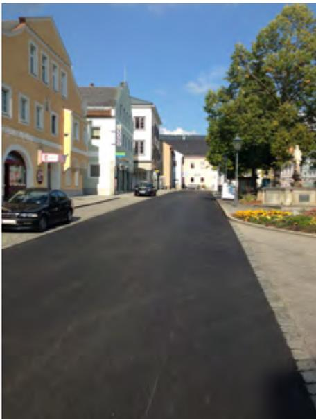
Durch Frost- bzw. Wasserschäden an der Tragschicht, die mit freiem Auge jedoch nicht ersichtlich sind, war es notwendig, die Straße mit einem neuen Fahrbahnbelag zu versehen, damit keine Mehrkosten entstehen.
