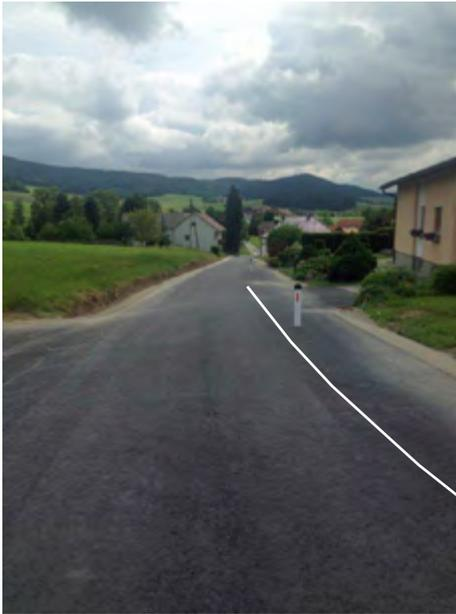
Nach Abschluss der Bauarbeiten für die Errichtung eines Reinwasserkanals durch die Baufirma Resch wurde vom WEV-Rohrbach die Baureitherstraße neu errichtet. In diesem Zusammenhang wurde zur Sicherheit der Fußgänger ein Gehweg berücksichtigt. Die Abgrenzung zur Fahrbahn wurde mittels Leitplöcken baulich begrenzt. Zur weiteren optischen Ausweisung wird noch straßenseitig eine Sperrlinie angebracht.
